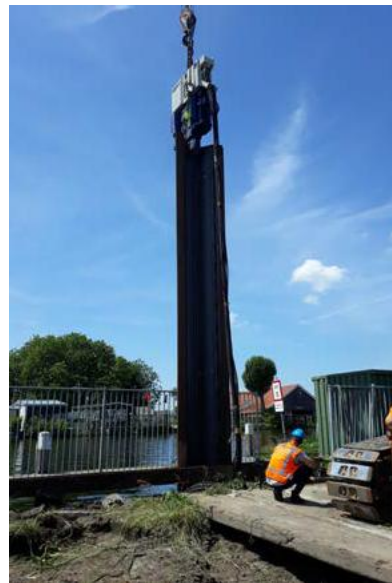
Installeren energiedamwand
