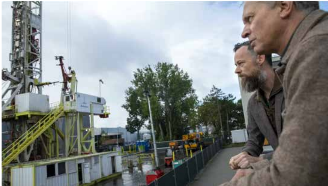
Op de TU Delft vindt een boring plaats voor het winnen van aardwarmte.
