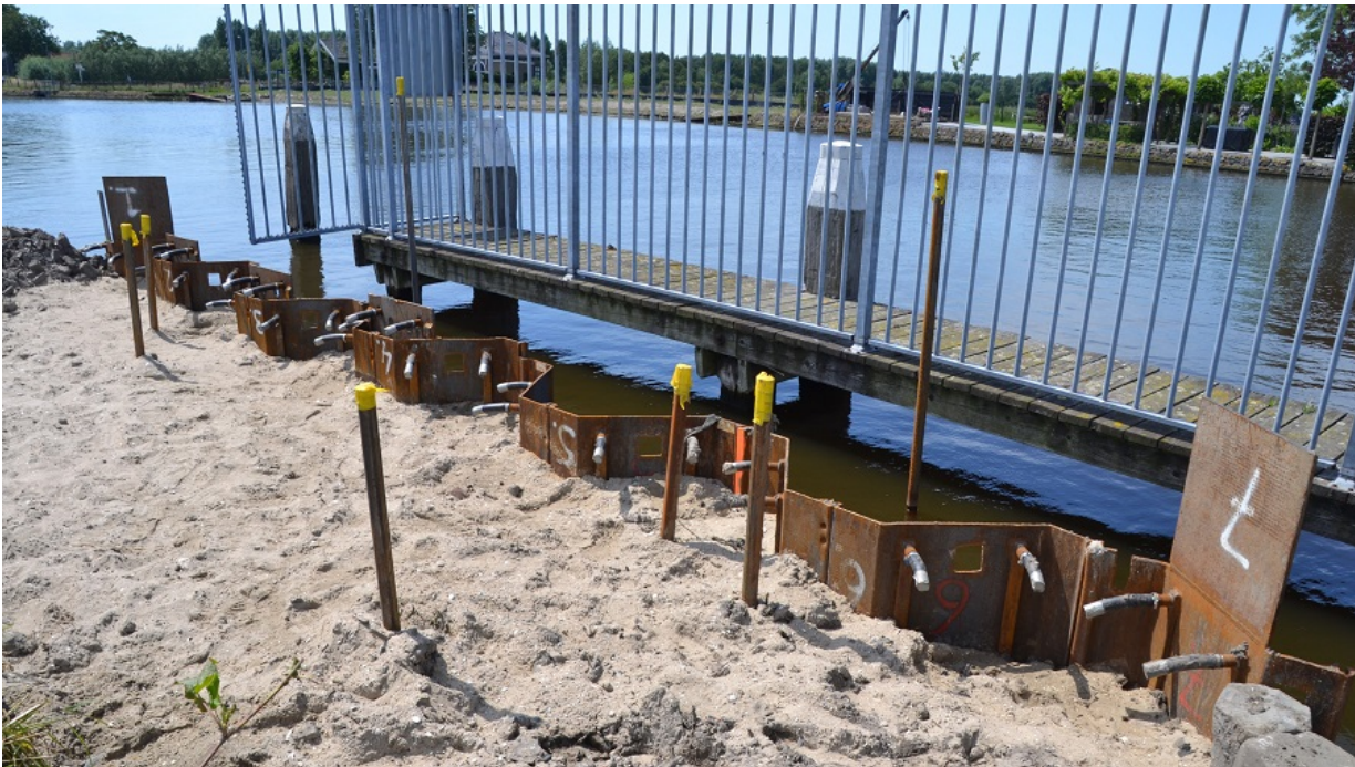
Beeld van de aanleg van de kademuur met een energiefunctie in De Zweth I foto: Gooimeer
