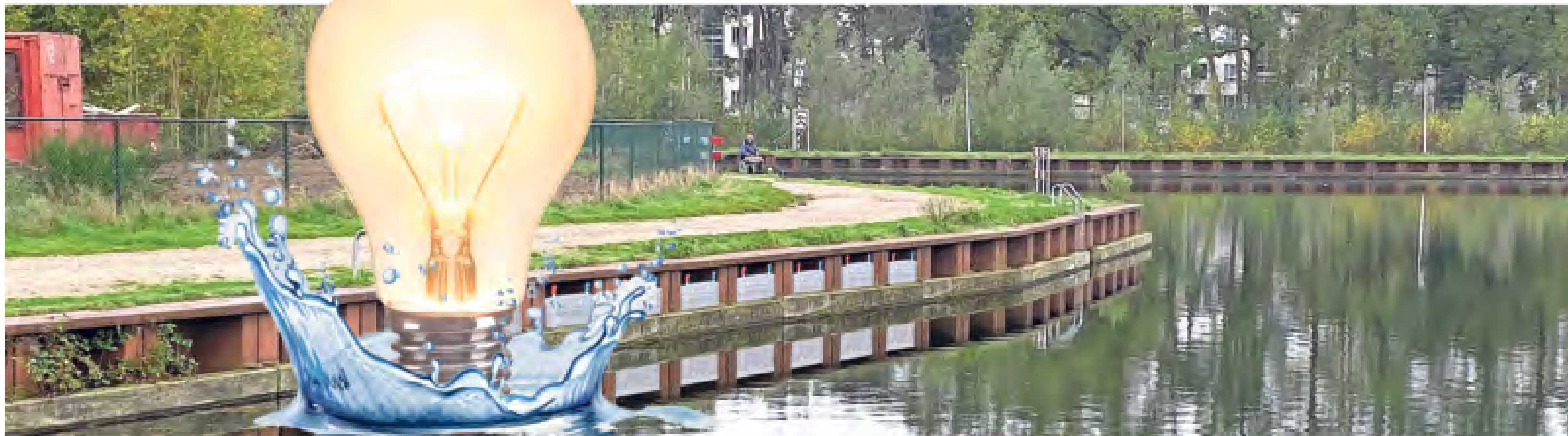
Kijkje vanaf het water op een voorzetelement in Tilburg.
