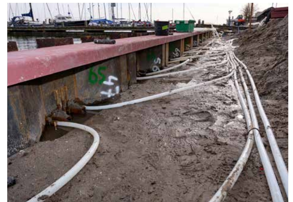
De energiedamwand kant gewoon met de bestaande technieken van trillen of drukken worden aangebracht.
