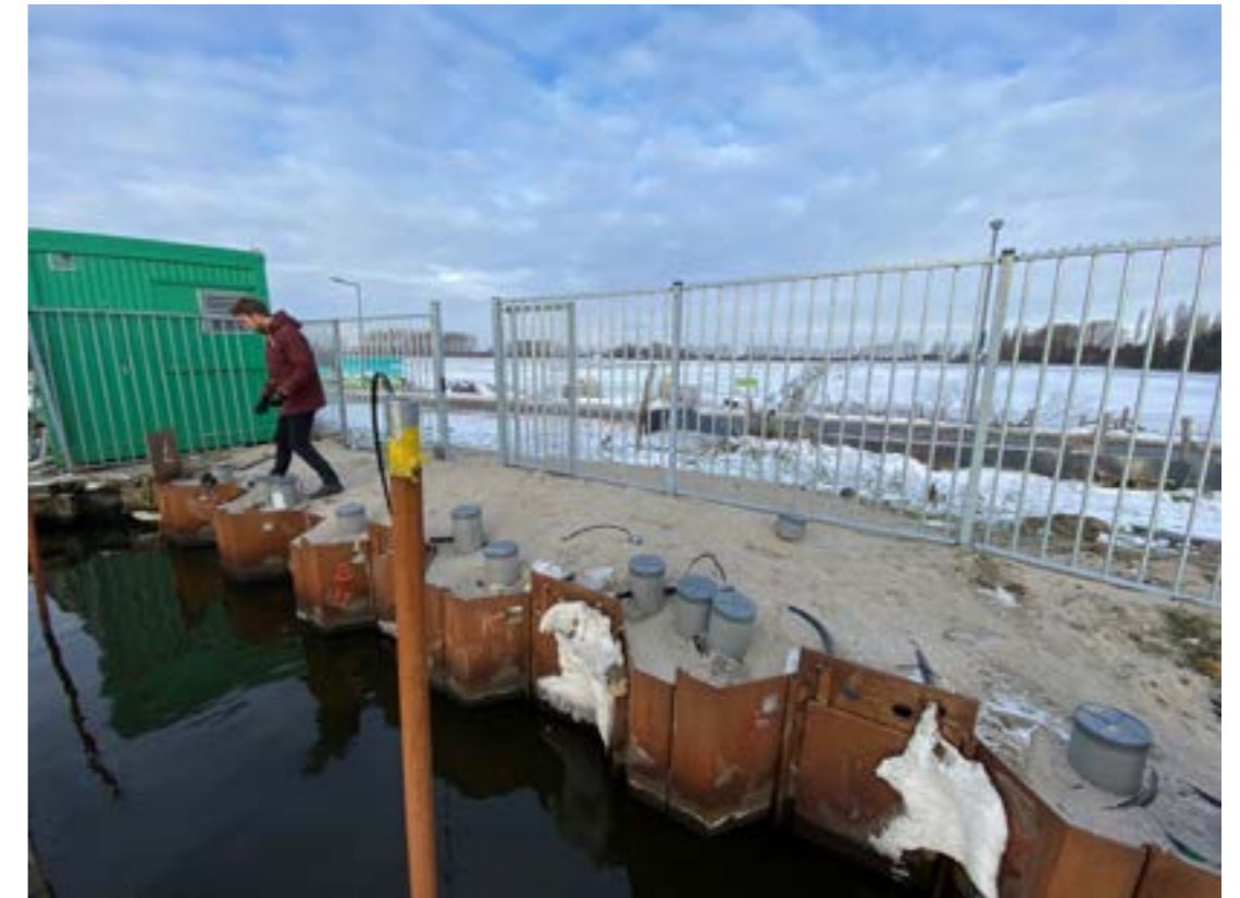
Inclinometing van de damwand (foto: Jacco Haasnoot)
